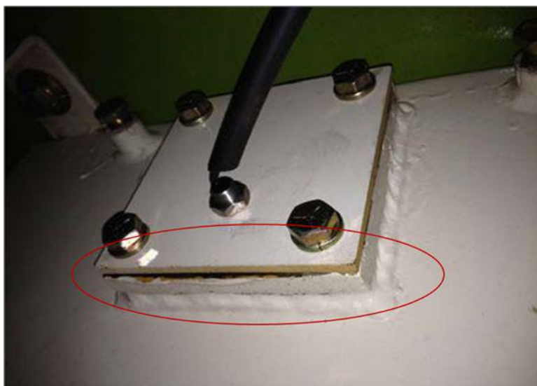
某客户现场照片
