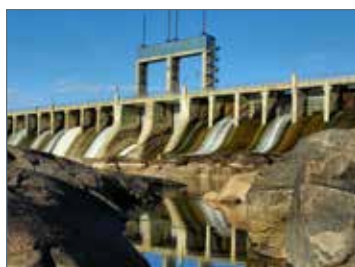
GENERACIÓN DE ENERGÍA
